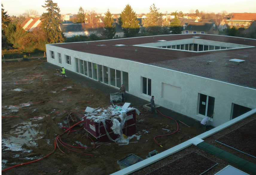
Fig. 8. Maison de Retraite du CCAS de Tours, green roof and garden
